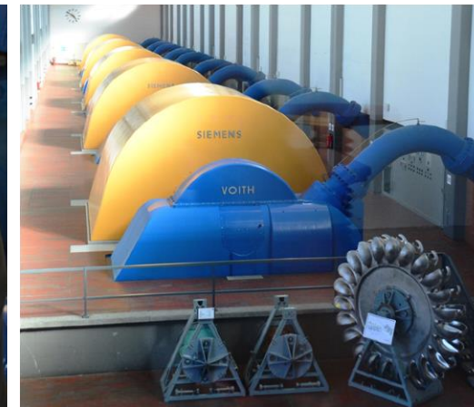
Kraftwerk Kaunertal 2-düsige Pelton in Tandemanordnung mit 40 MW
