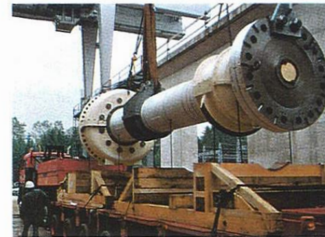
Baustellenmontage: Einfahren von Laufrad und Welle,
